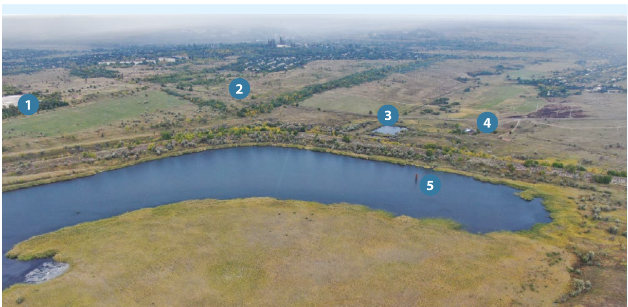
Рисунок 25. Мулонакопичувач № 2 та інші об'єкти: ❶ накопичувач № 1 Інкору, ❷ автодорога, ❸ земляний резервуар, ❹ насосна станція, ❺ водоприймальна башта. Фото: ОБСЄ, 2019
